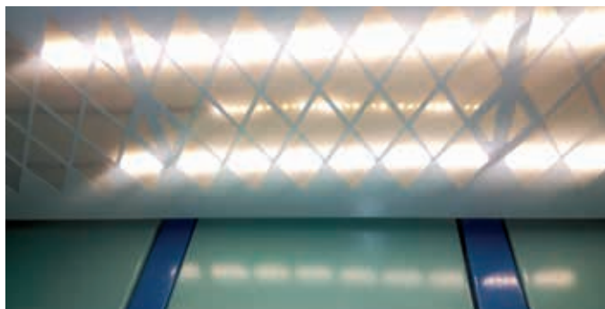
Фото 2. Так выглядят переоборудованные светильники, оснащенные светодиодными лентами во всех лифтах товарищества
