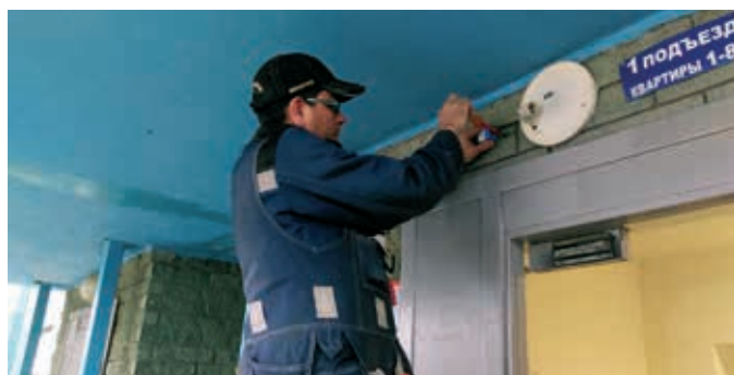
Фото 4. Электрик ТСЖ А. Долгов устанавливает фотореле на освещение входной группы жилого дома № 42 п. 1
